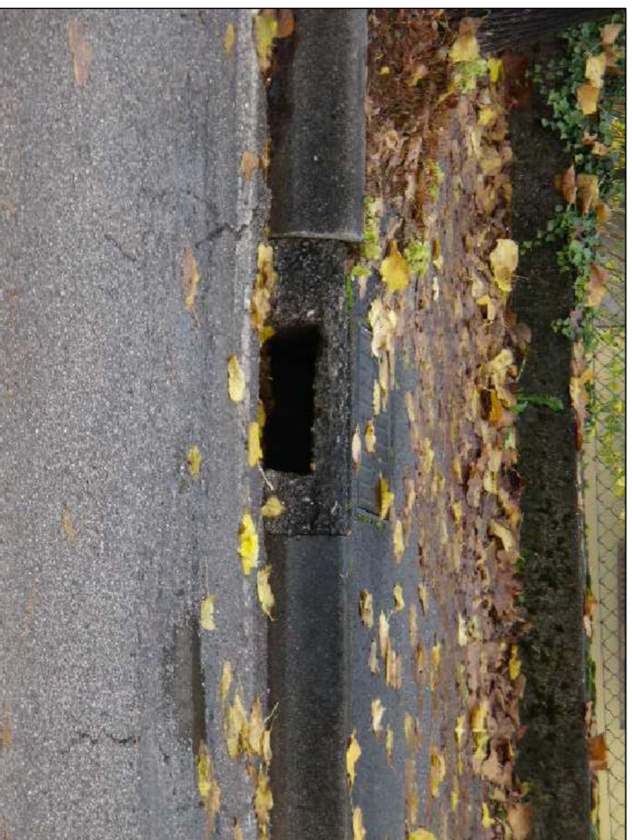
PARTICOLARE BOCCA DI LUPO ESISTENTE
