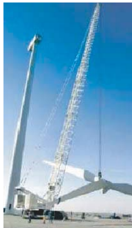
Fase di montaggio delle pale alla torre
