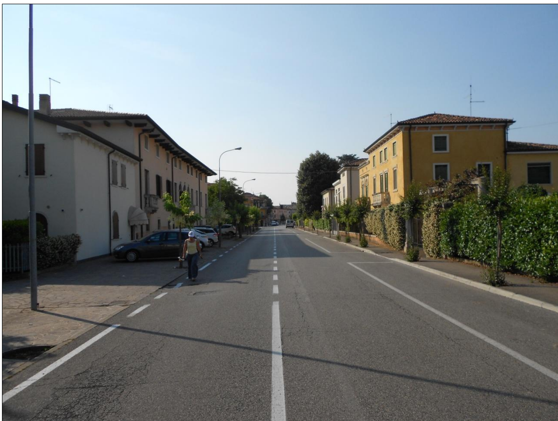
Fig. 1 - Tratto di via XX Marzo fra via Roma e via Contra' dei Molini
